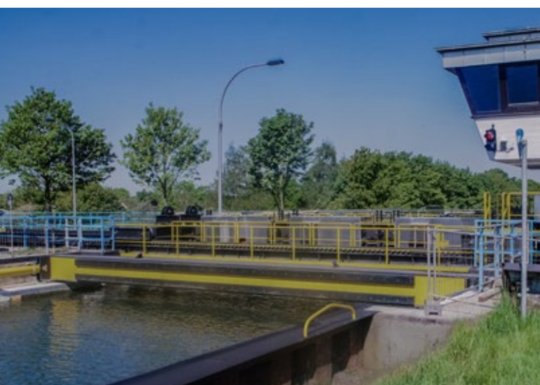
Dämpfung für Stoßbalken vor Schleuse // Damping for bumper beam in front of water lock
